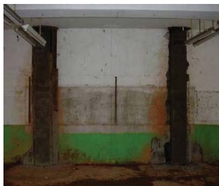
複合柱補強實景
