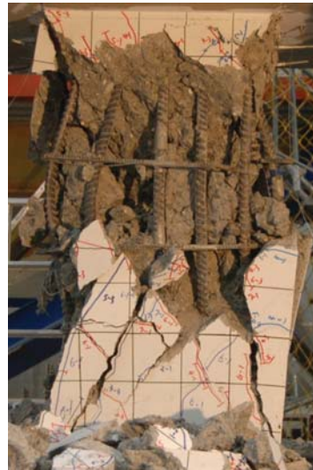
黃世建、黃益堂，「鋼筋混凝土極短柱受剪破壞之耐震行為曲線研究」，NCEE-08-027。
